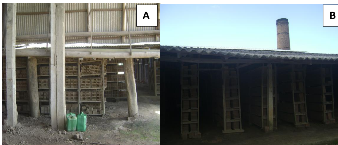
Figura 10: Fotografia das Condições precárias das edificações. (A) Prateleiras de madeira; (B) teto baixo.
