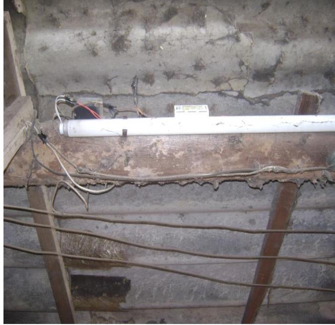
Figura 11: Fotografia das condições precárias das instalações elétricas, fios expostos.
