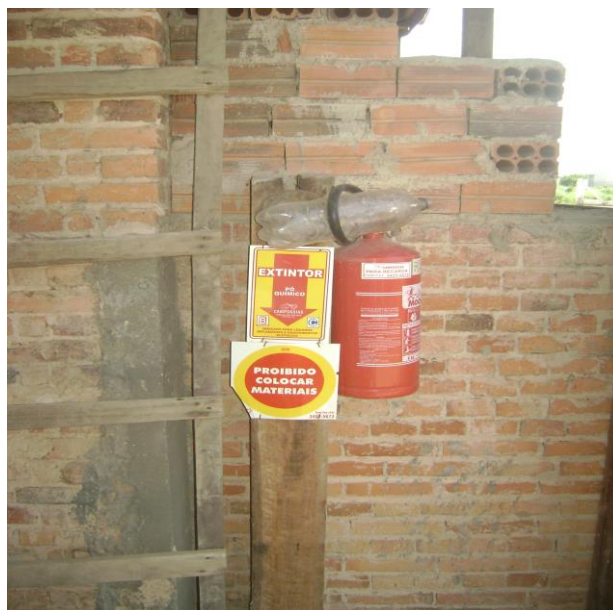
Figura 18: Fotografia de extintor de incêndio.
