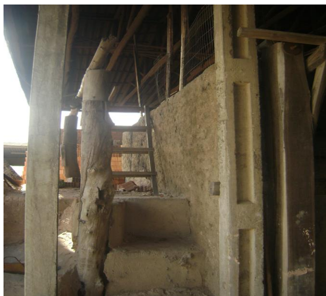
Figura 15: Fotografia das escadas de acesso aos fornos em condições precárias.
