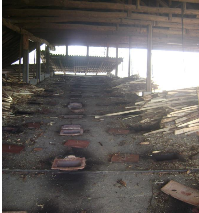
Figura 16: Fotografia de obstáculos em áreas de circulação e risco de queda em altura.
