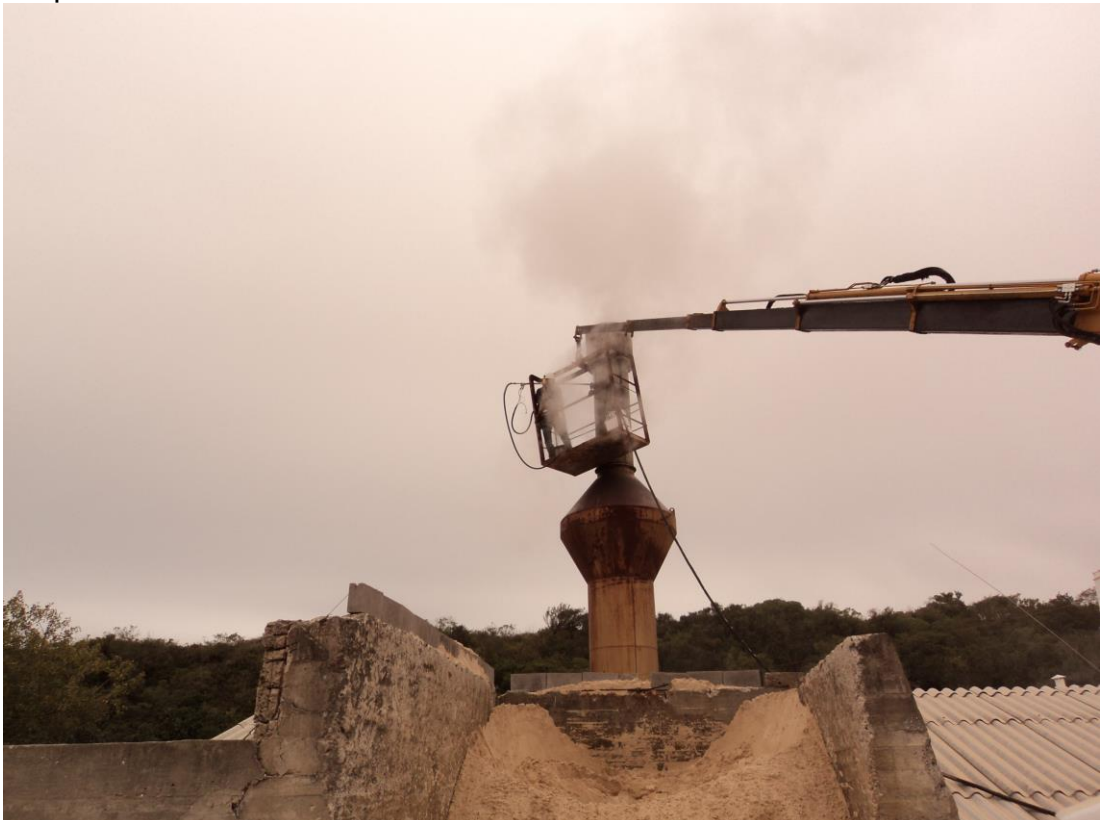
Figura 6: Realização de amostragem isocinética com caminhão munck e cesta suspensa.
