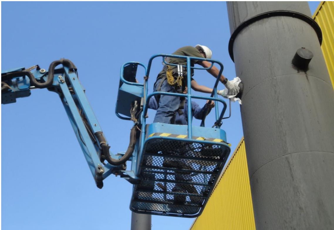
Figura 10: Amostragem isocinética com o auxílio de plataforma para trabalho em altura.
