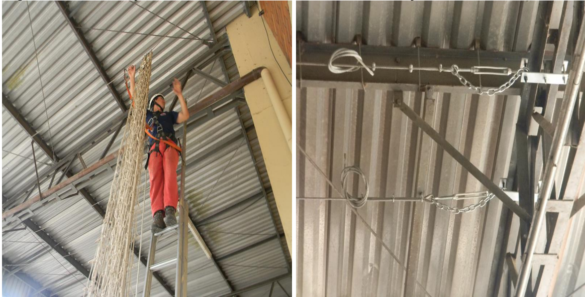
Figura 03 - Instalação de linha de vida e redes de contenção
