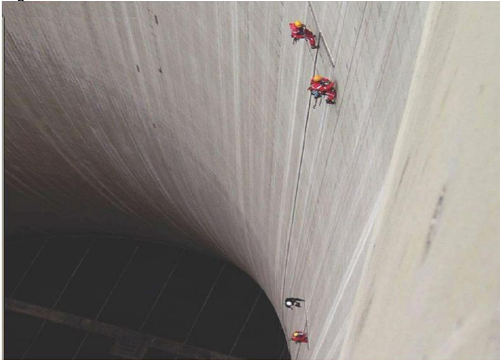
Figura 1 – Trabalho em altura elevada
