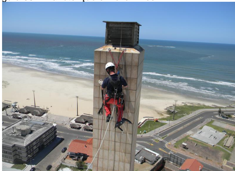
Figura 06 – Manutenção em chaminés
