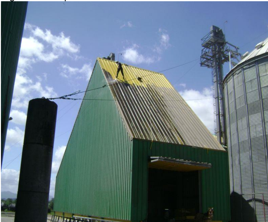
Figura 2 – Limpeza de Silos
