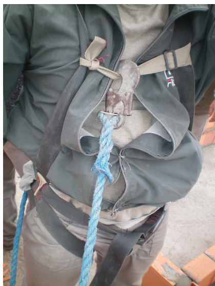
Figura 11 – Equipamento de segurança inadequado.
