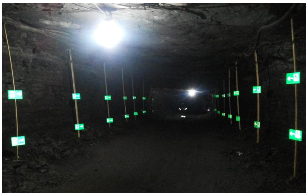
Figura 11: Galeria sinalizada em ambos os lados com iluminação.
