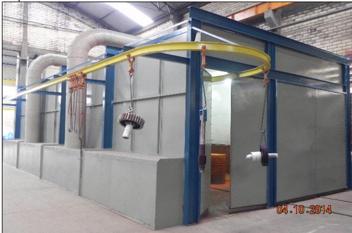
Figura 8 - Exterior da Cabine de pintura da Natreb Indústria e Comércio de Máquinas Ltda.
