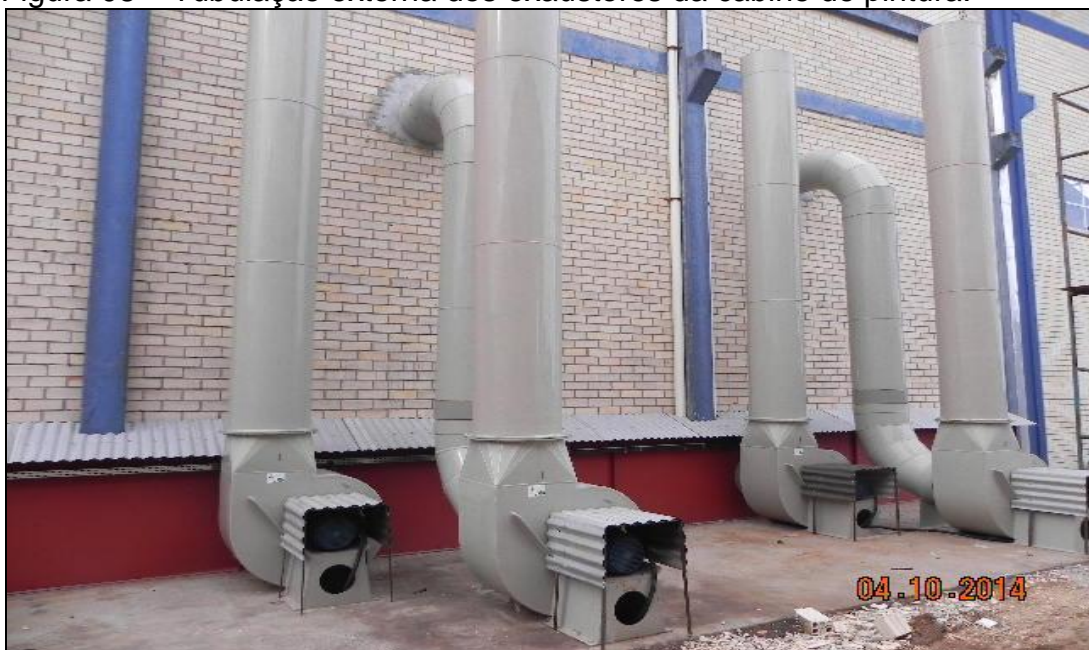
Figura 08 – Tubulação externa dos exaustores da cabine de pintura.
