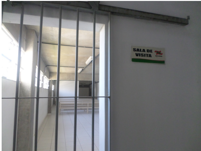
Figura 14 – Entrada sala de visitas
