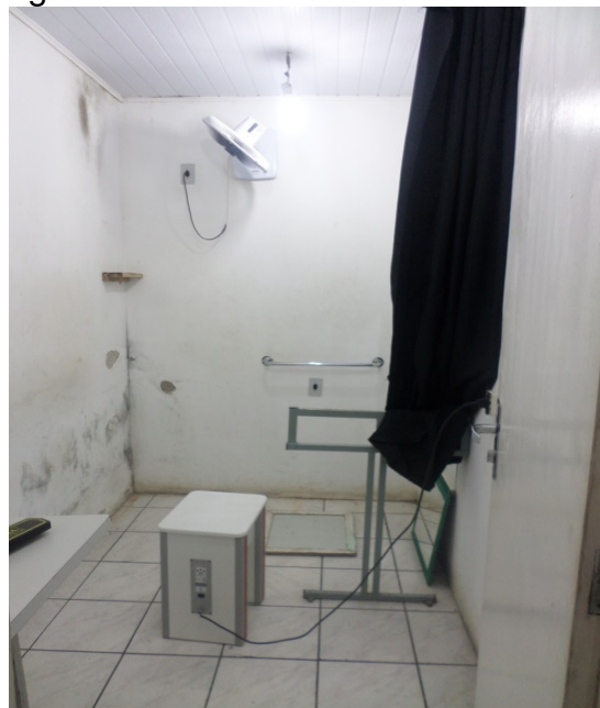
Figura 5 – Interior Sala de Revista
