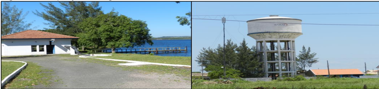
Figura 11: captação de água no Faxinal e reservatório na Zona Nova
