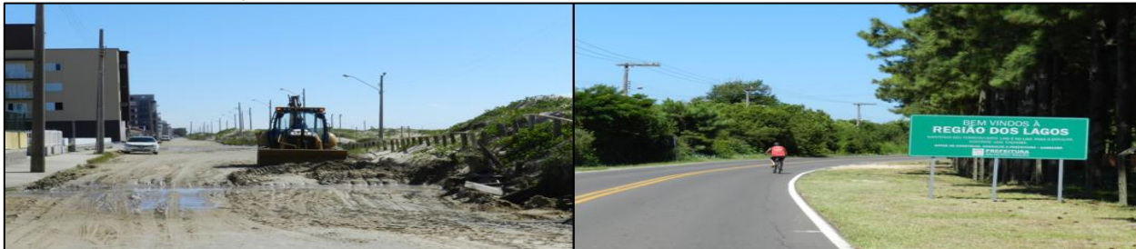
Figura 7: manutenção da Avenida beira mar e asfalto na rodovia Jorge Fortulino
