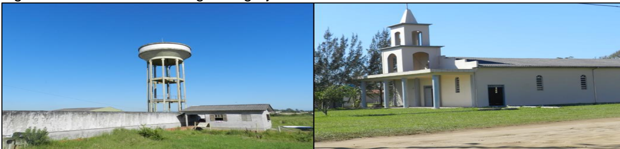
Figura 12: reservatório de água e igreja na Barra Velha
