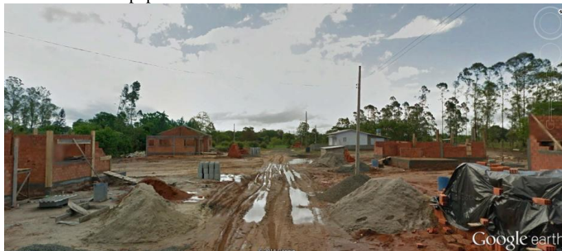
Figura 12 - Vista panorâmica da parte baixa (cota entre 2,0 e 3,0 metros) da região do Bairro Jardim Cibele, onde à época do imageamento, estavam sendo construídas casas populares.
