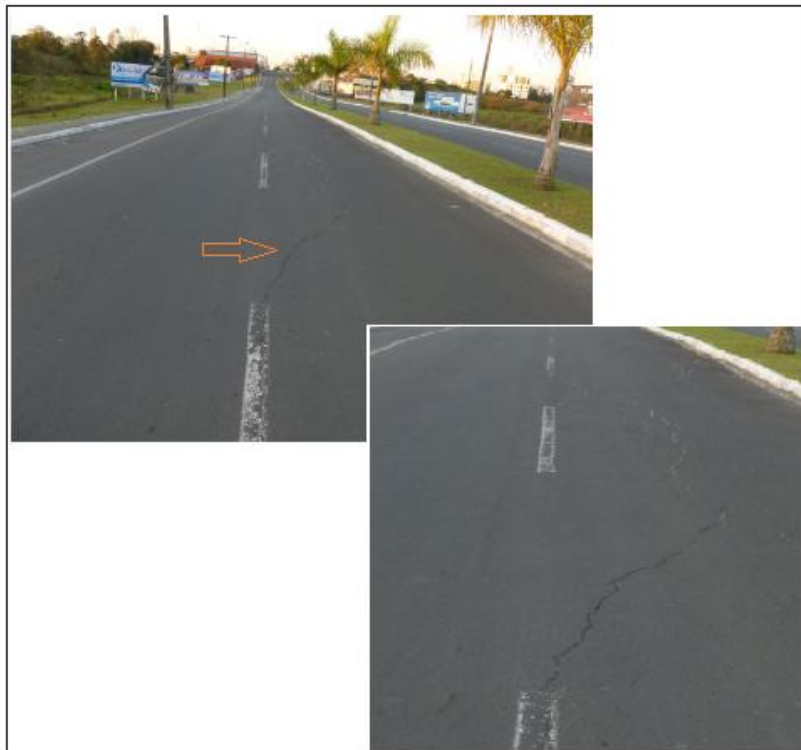
Figura 20- Deformações em camada asfáltica na Avenida XV de Novembro.
