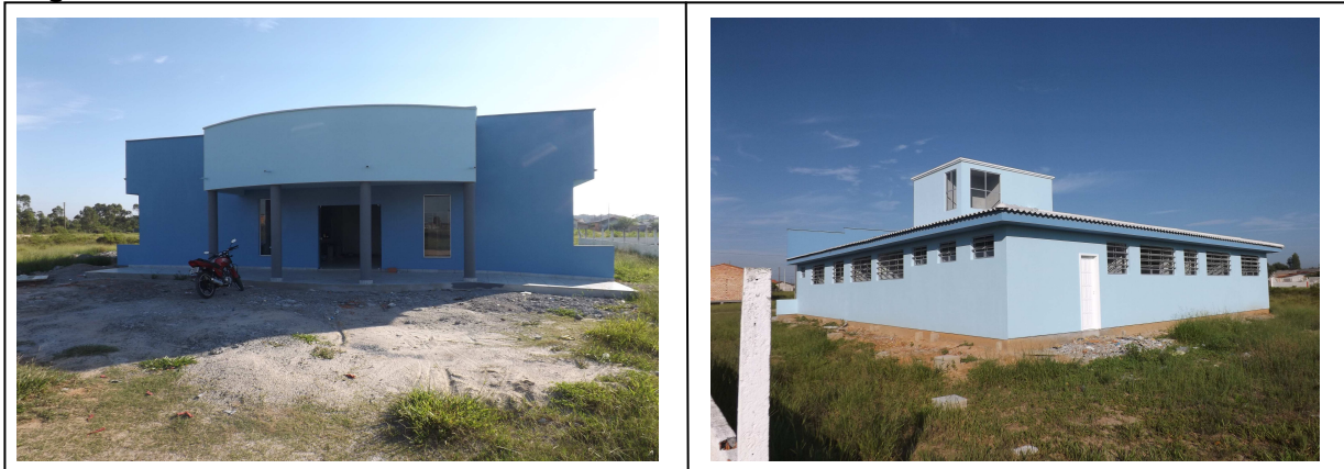
Figura 4: Fachada frontal, fundos e lateral da obra
