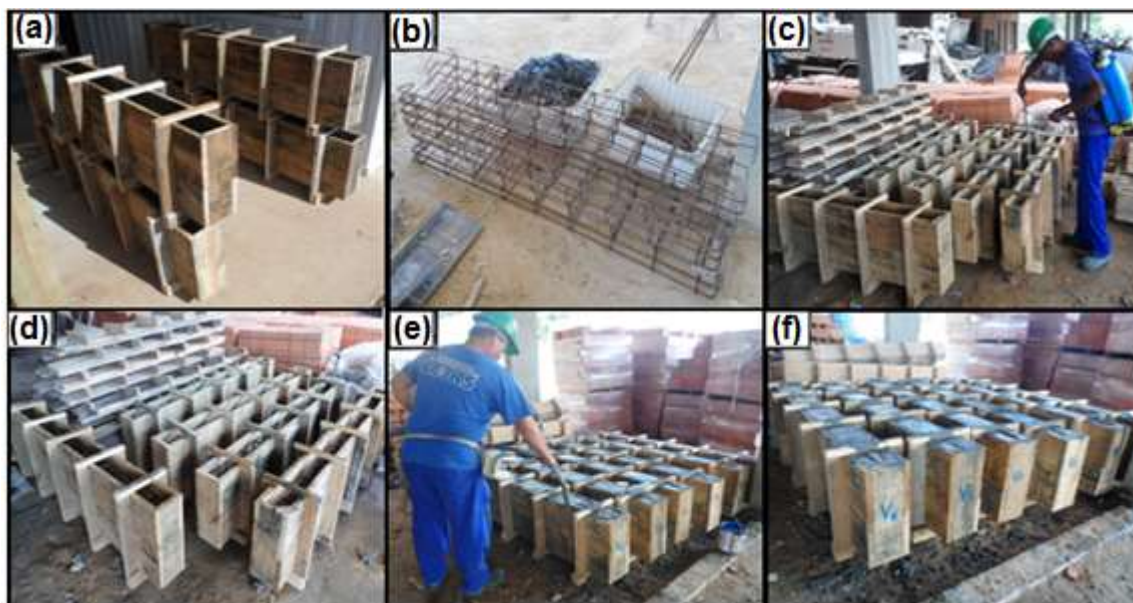
Figura 5: Confeção das vigas de concreto armado.
