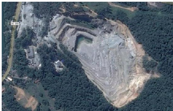
Figura 1 – Localização da Pedreira
