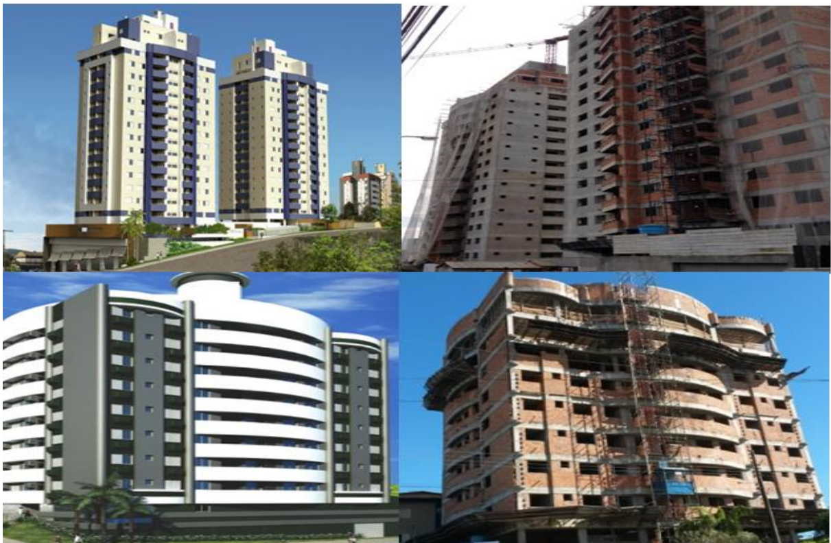
Figura 3: Empreendimento 1 e 2 estágios atual da obra.
