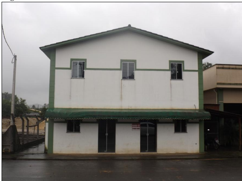
Figura 19 - Casa de Banha
