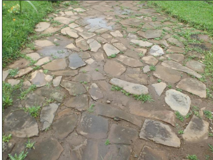
Figura 23 - Calçada de pedra
