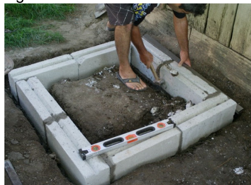
Figura 5 – Assentamento da base.
