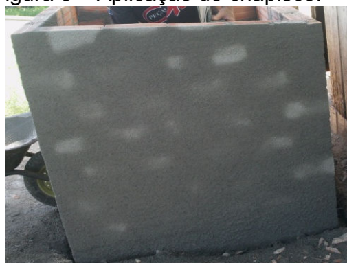
Figura 8 – Aplicação do chapisco.
