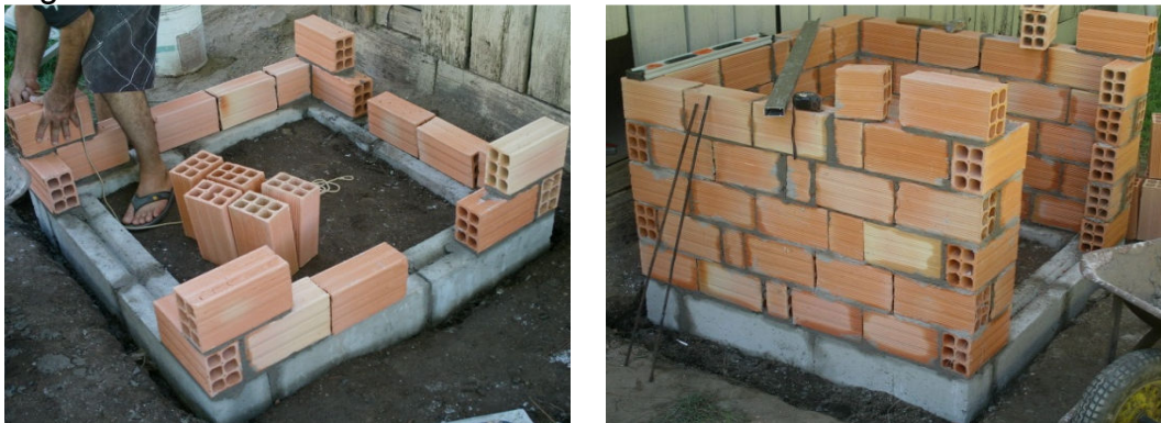
Figura 6 – Assentamento da alvenaria.
