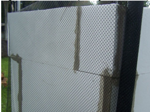
Figura 13 e 14 – Aplicação da tela polietileno e da argamassa sobre a tela.
