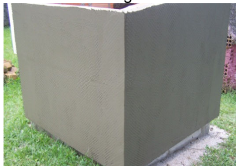
Figura 15 – Revestimento Argamassa ACII sobre a Tela.
