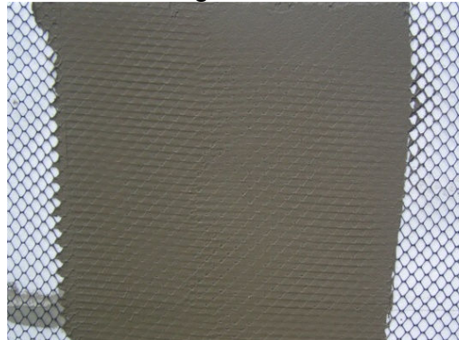
Figura 13 e 14 – Aplicação da tela polietileno e da argamassa sobre a tela.
