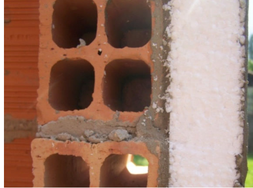
Figura 12 – Detalhe do Revestimento Cappotto
