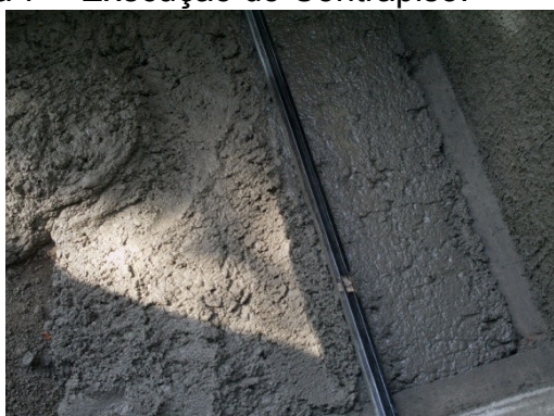
Figura 7 – Execução do Contrapiso.
