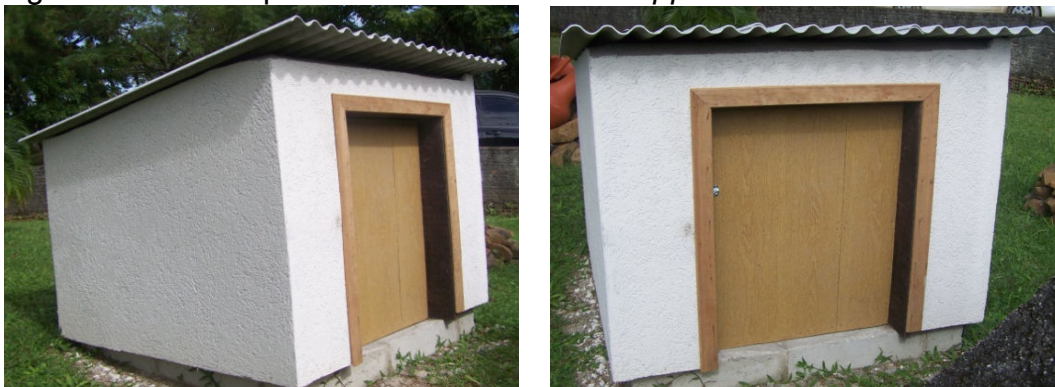
Figura 17 – Protótipo Baseado no Sistema Cappotto
