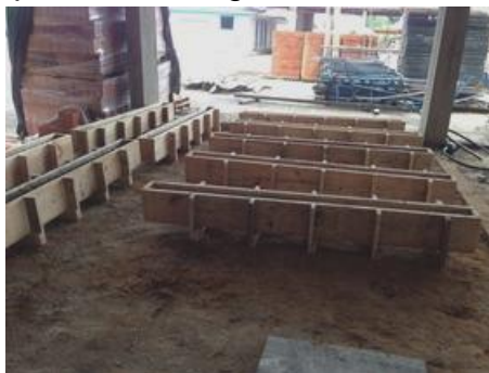
Figura 1 – Formas prontas para concretagem.
