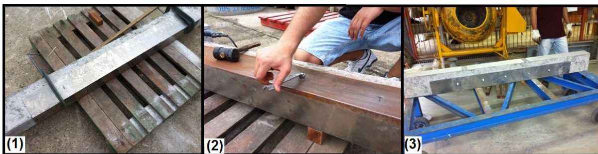
Figura 2: Aplicação de reforço do perfil de aço com chumbadores
