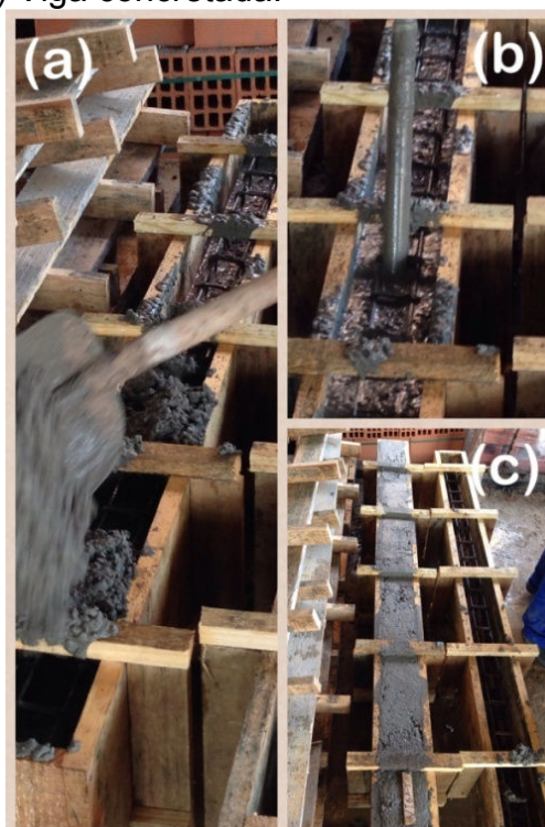
Figura 7 – Concretagem das vigas – (a) Colocação do concreto na forma; (b) Vibração do concreto; (c) Viga concretada.
