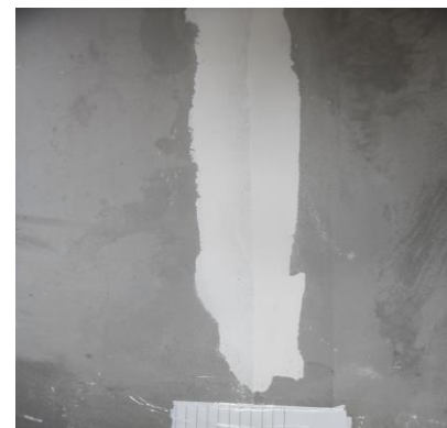
Figura 10- Reincidência trinca 3
