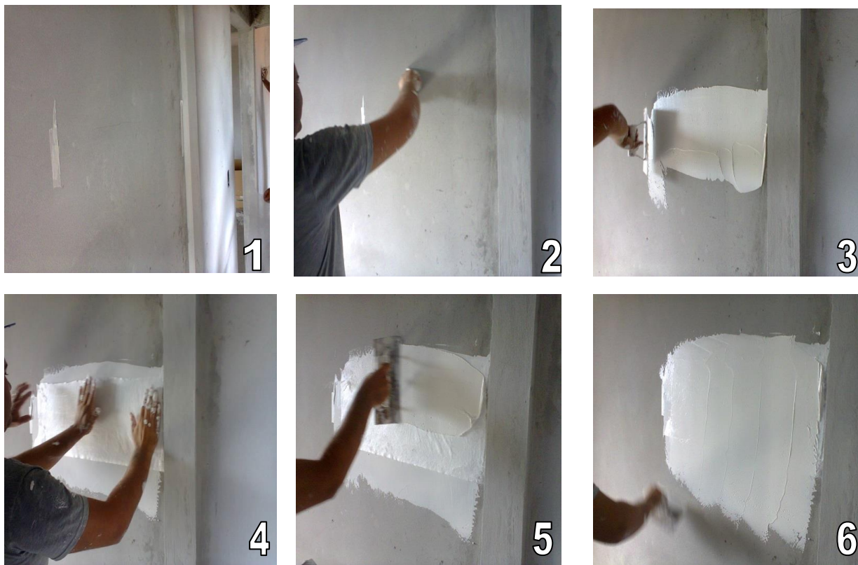
Figura 1 - Método 1 Aplicação de tela de fibra de vidro e massa PVA.
