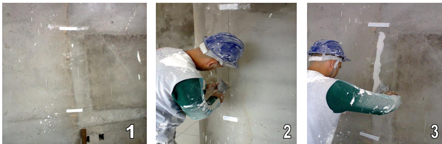
Figura 3 – Método 3 Abertura da trinca com espátula e preenchimento com massa PVA
