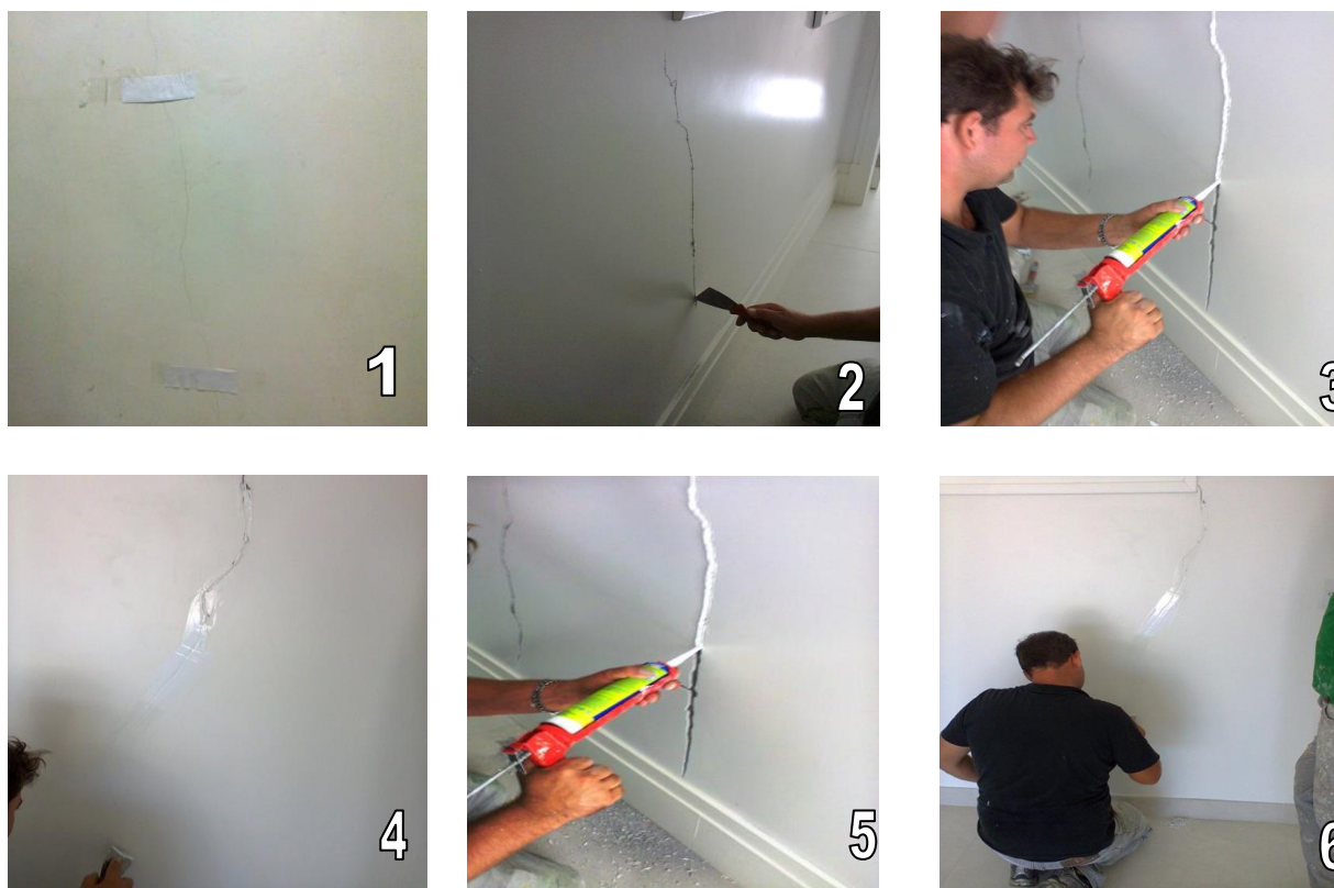
Figura 2 – Método 2 Abertura da trinca com espátula e preenchimento com selante elástico a base de poliuretano.
