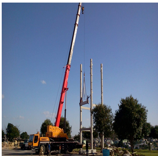
Figura 04 e 05: Operários sentados sob a peça pré moldadas sendo içada pelo equipamento de guindar. – Montagem de Vigas Intermediária
