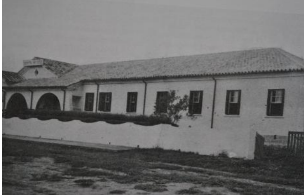
Figura 22 - Hospital São Roque
