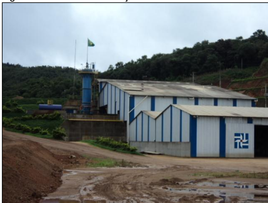
Figura 4 - Pavilhão - Instalação de Beneficiamento.
