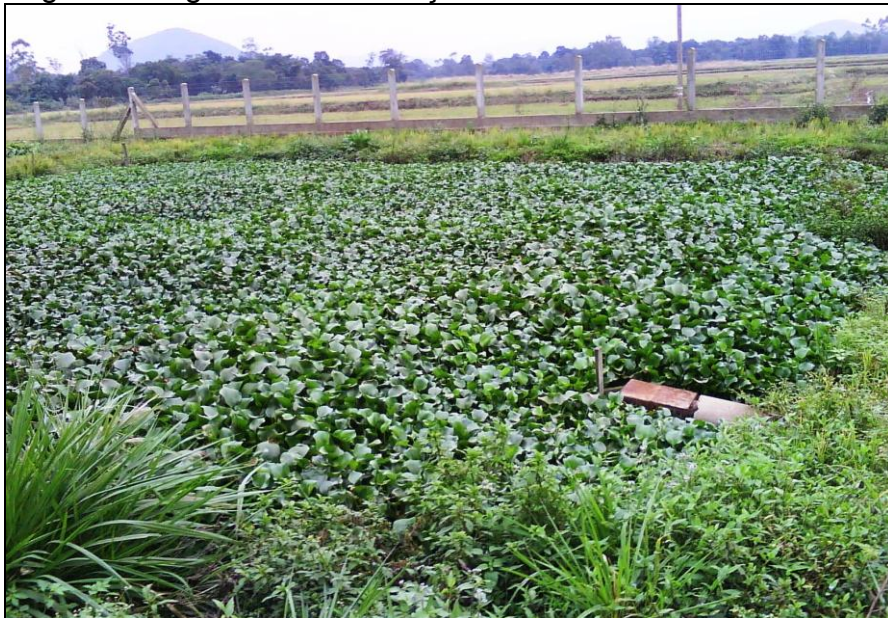
Figura 7: Lagoa de estabilização com macrófitas
