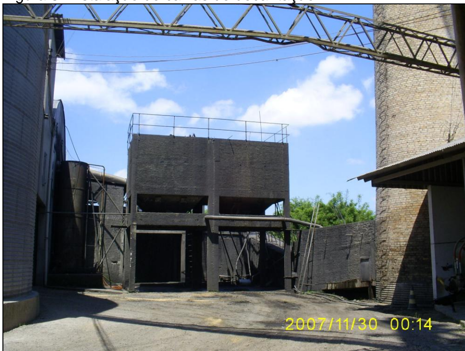
Figura 8: Instalação de caixas de decantação
