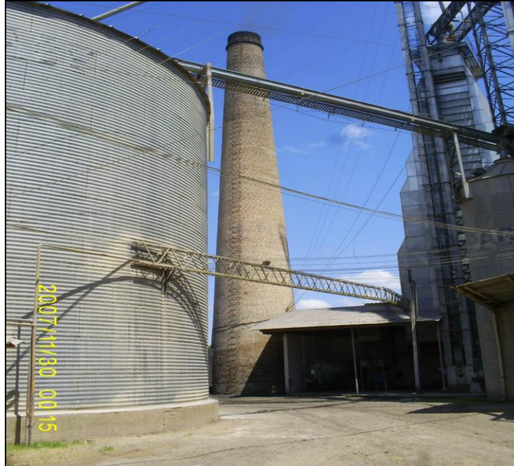
Figura 5: Lavador de Gases/Chaminé
