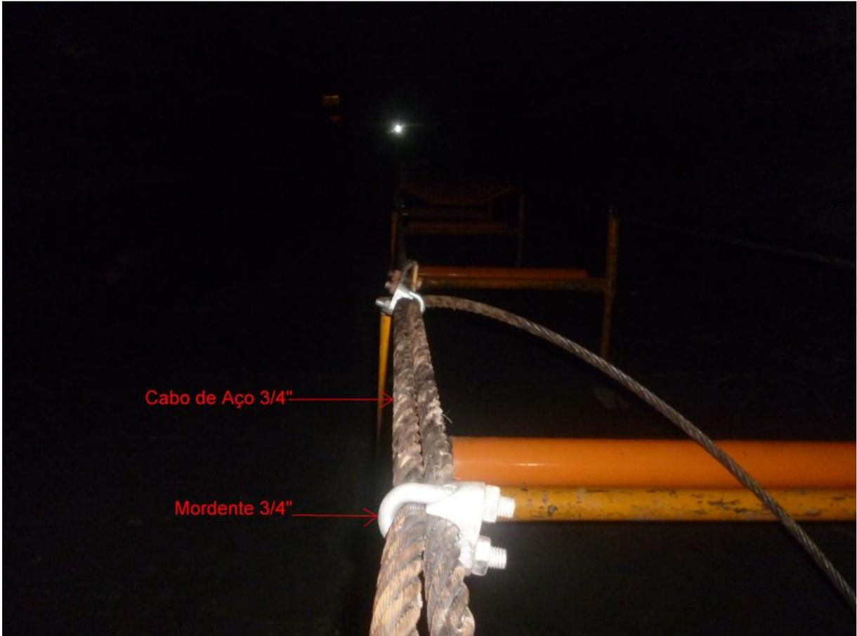
**Foto 13:** Tensionamento do cabo de aço durante montagem. **Fonte:** Do autor.
