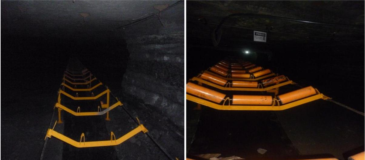
**Foto 15:** Processo de centralizar e colocar roletes nos cavaletes. **Fonte:** Do autor.
