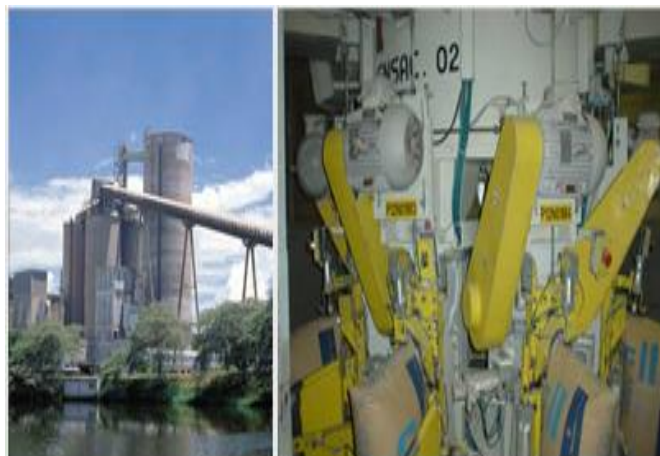
Figura 8: Silos de cimentos e ensacadeiras.
