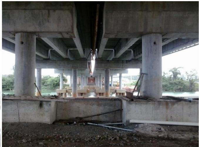
As Figuras 06 e 07 ilustram o detalhamento das vigas estudadas. As duas vigas tem comprimento de 25,10 metros e altura de 1,72 metros. A resistência característica especificada em projeto é de 35 MPa.
