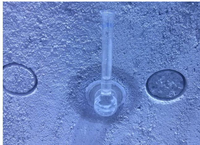
Figura 2: Cachimbos de vidro fixados no revestimento.
