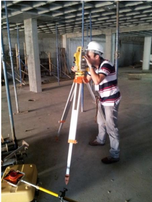
Figura 04: Locação dos pontos utilizando estação total.
