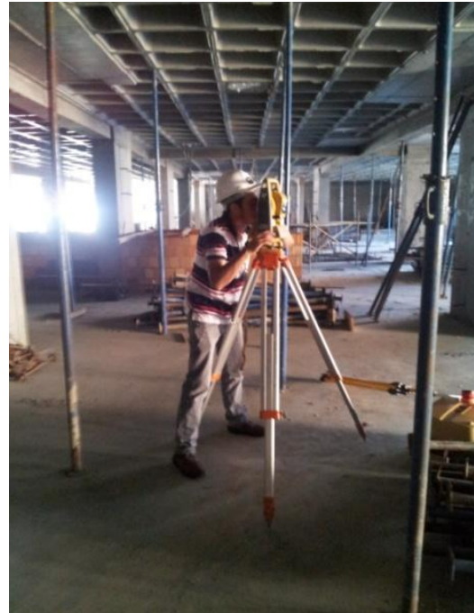
Figura 04: Locação dos pontos utilizando estação total.
