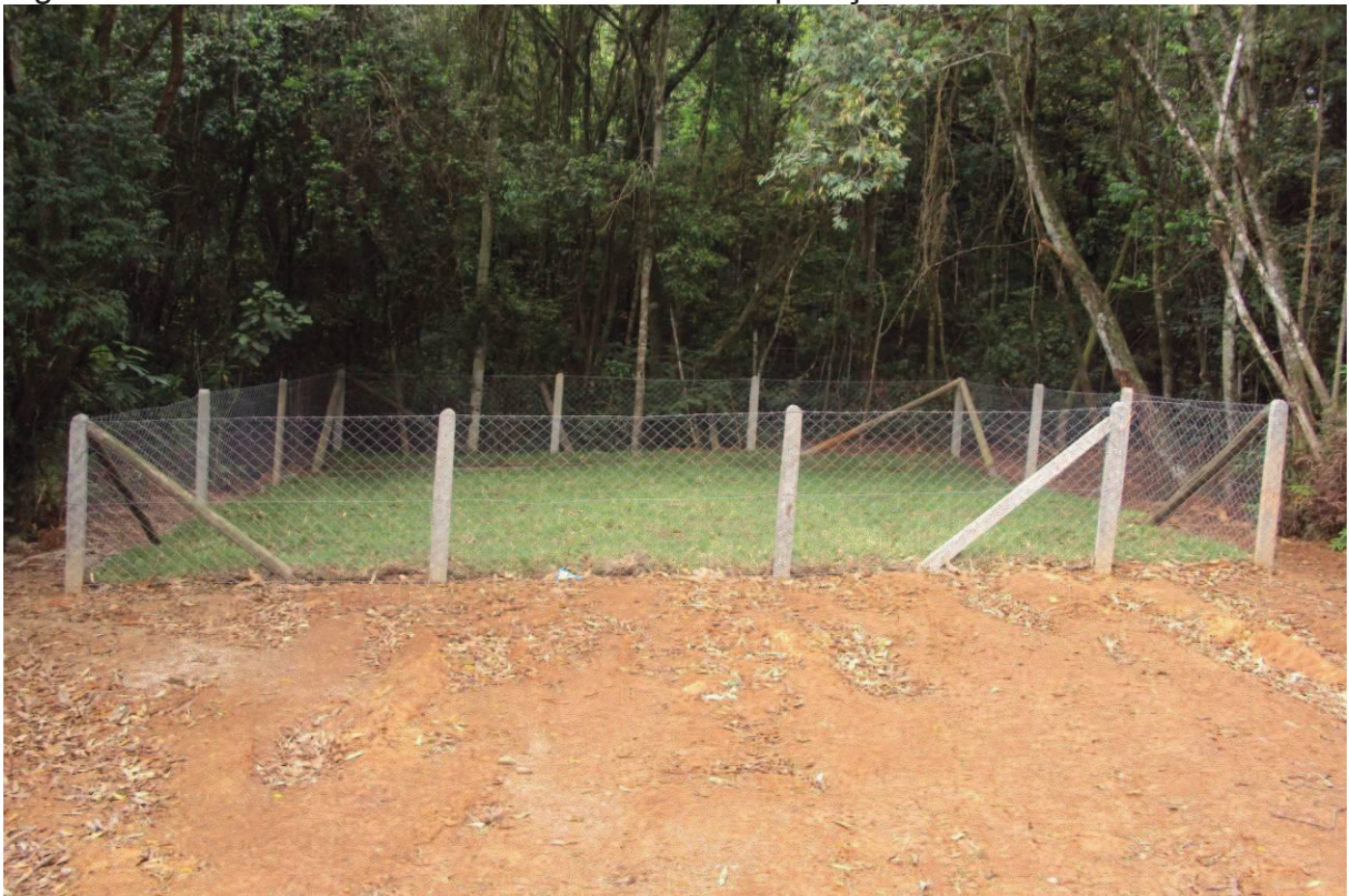
Figura 11 – Plano inclinado em fase final de recuperação.
