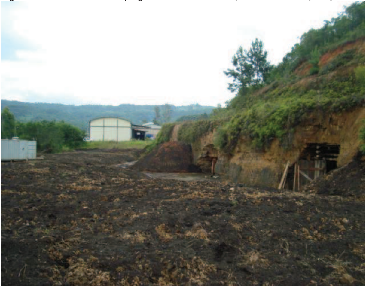
Figura 5 - Boca de mina do tipo galeria de encosta em processo de recuperação.
