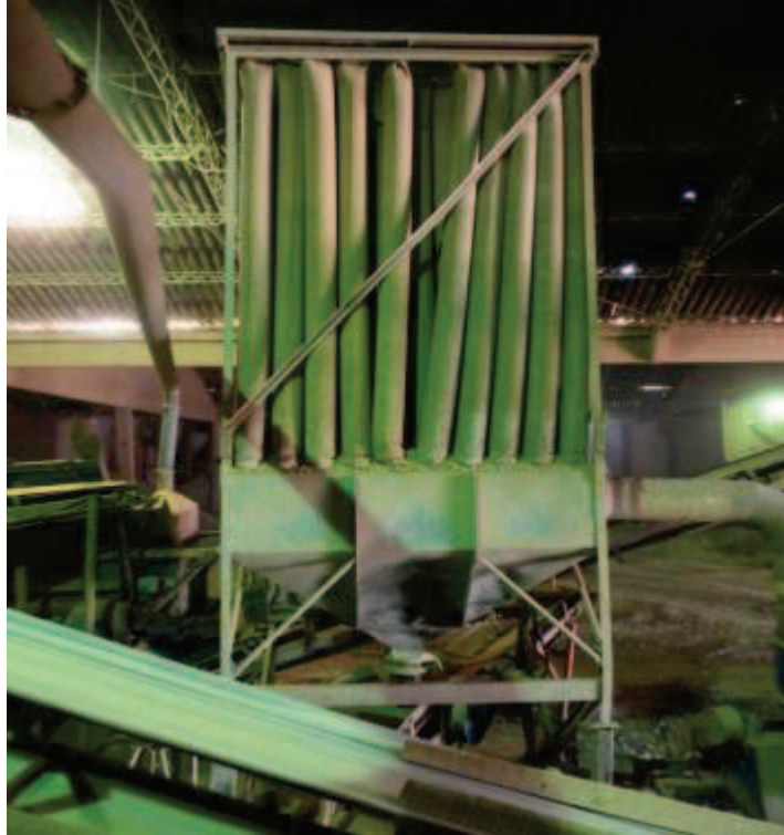
Figura 22 – Filtro de Mangas 1: sem revestimento
