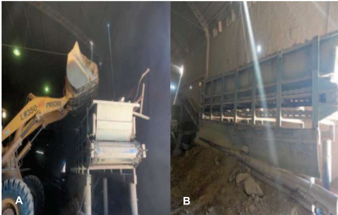
Figura 14 – A – Pá-carregadeira transportando as argilas ao caixão esteira; B – Caixão esteira: etapa de secagem
