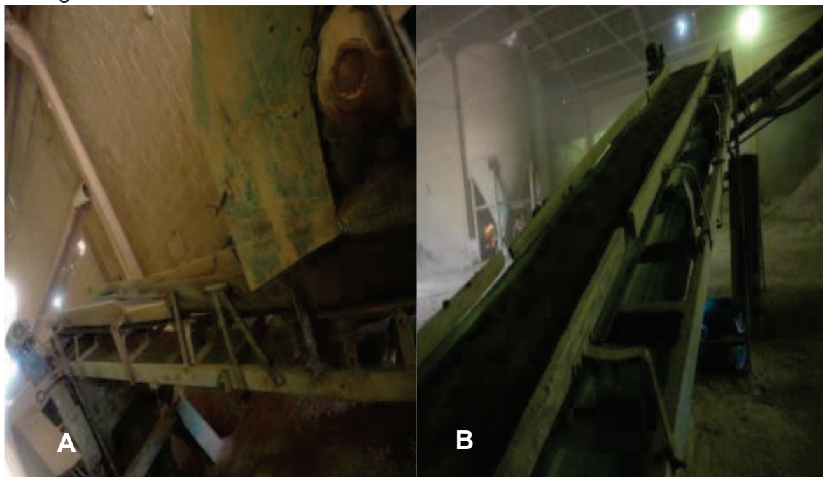
Figura 15 – A – Transporte da argila do caixão esteira ao britador; B – Transporte da argila do britador aos secadores
