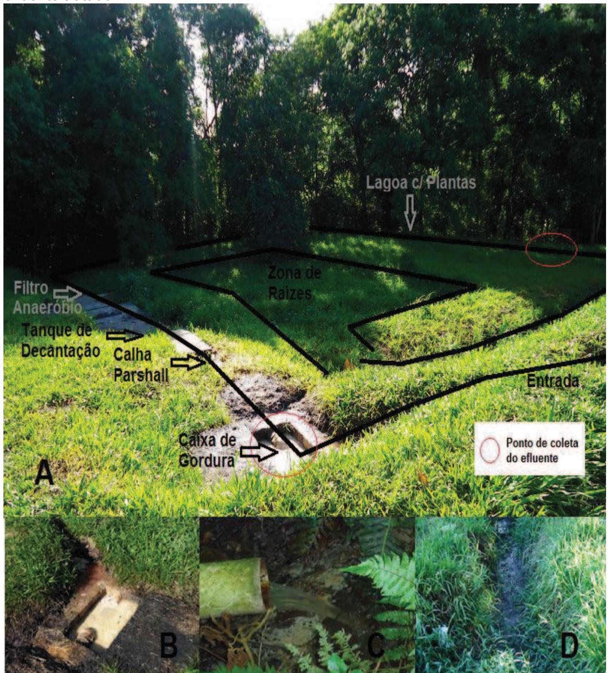
Figura 08 – (A) Etapas da estação de tratamento de efluentes (ETE), (B) Ponto de coleta efluente bruto, (C) Efluente saída filtro anaeróbico, (D) Ponto de coleta efluente tratado.
