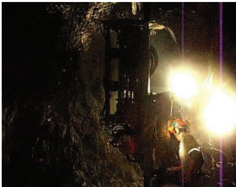
Figura 4 - Perfuratriz de teto.
