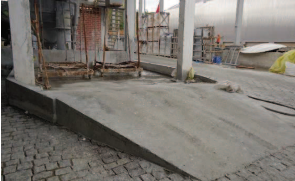
Figura 24 – Contenção nova adequada
