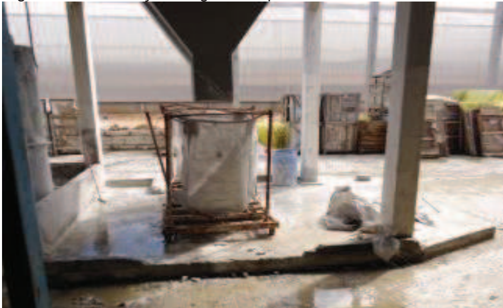
Figura 23 – Contenção antiga inadequada
