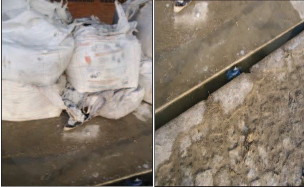
Figura 30 – Área de armazenamento do lodo da ETE acondicionado em Big-bags , com contenção inadequada
