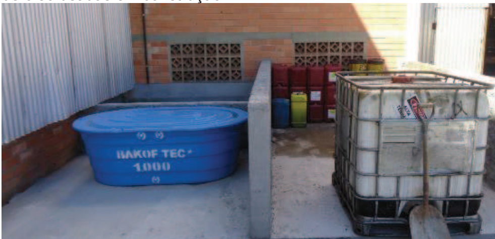
Figura 27 – Armazenamento adequado de óleo usado e embalagens de óleo usadas em construção
