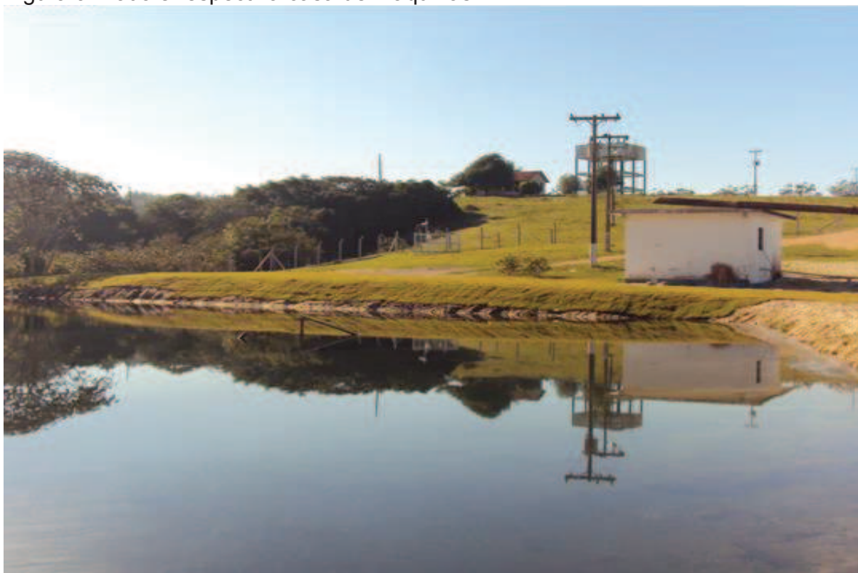
Figura 9: Pátio e respectiva casa de máquinas.
