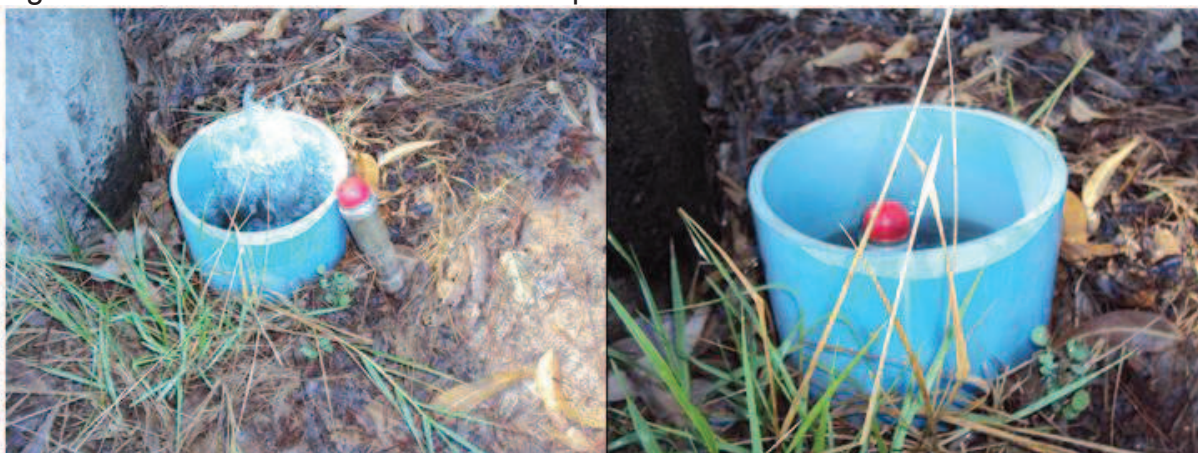
Figura 14: Ventosa aberta e fechada respectivamente.
