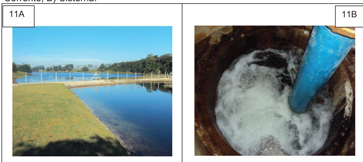
Figura 11: A) Detalhe de talude entre reservatório de captação e lagoa Arroio Corrente; B) Cisterna.
