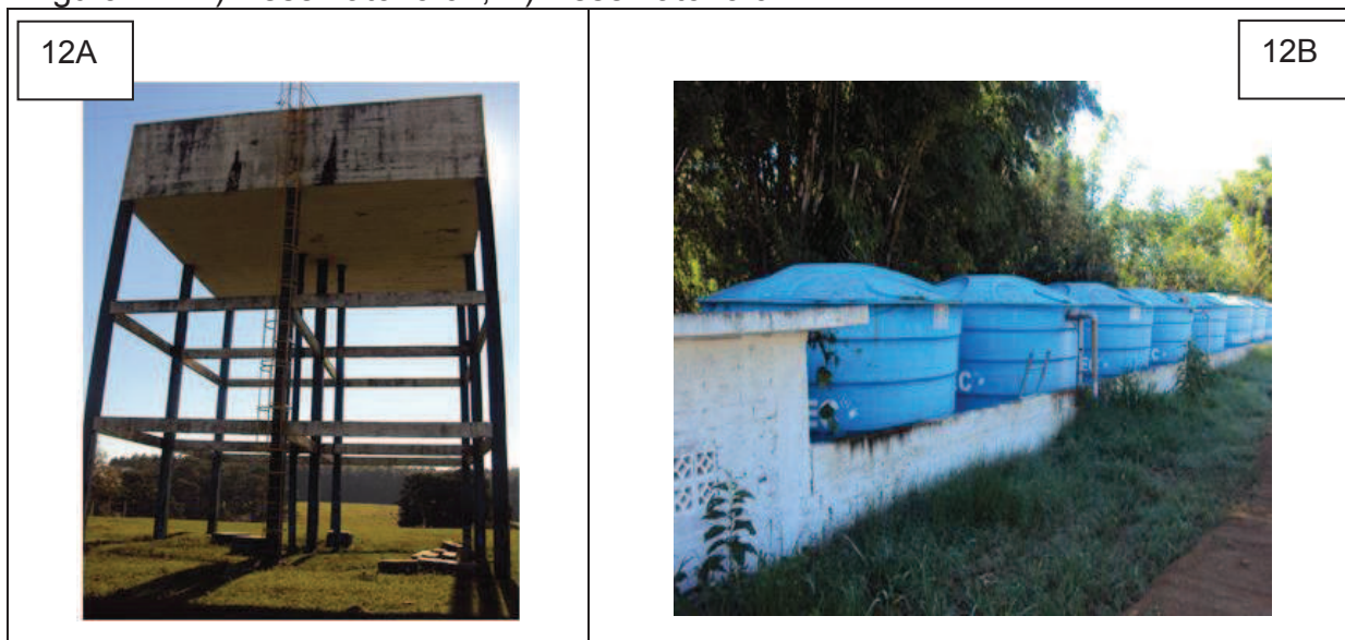
Figura 12: A) Reservatório 01; B) Reservatório 02.
