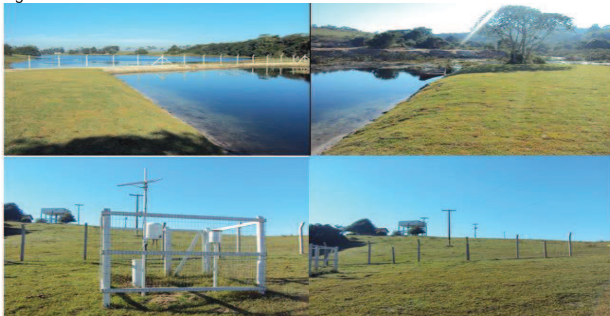
Figura 19: Pátio da ETA I.
