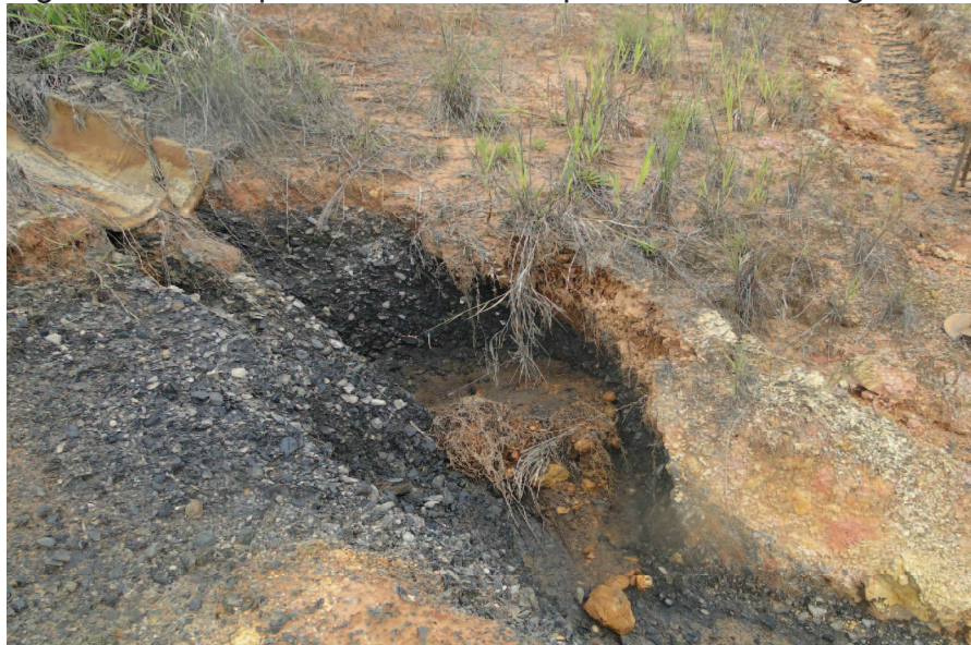
Figura 11 - Rompimento do lacre impermeabilizante logo abaixo do canal.
