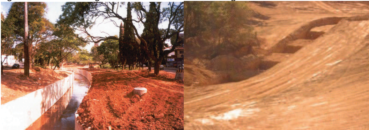
Figura 4 - Canal retangular de concreto e canal retangular em terra.
