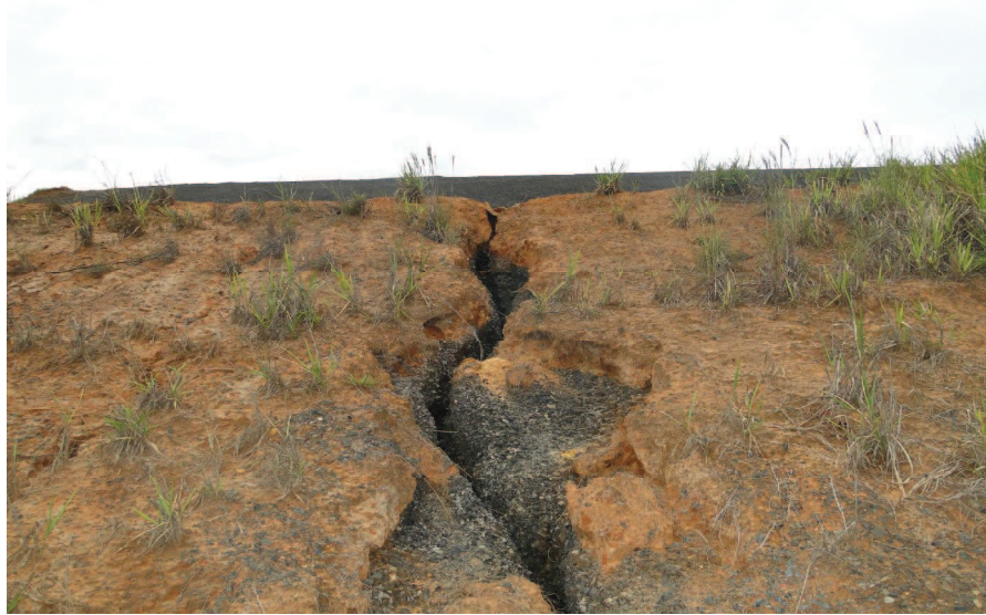
Figura 10 - Processos erosivos com exposição de rejeito.
