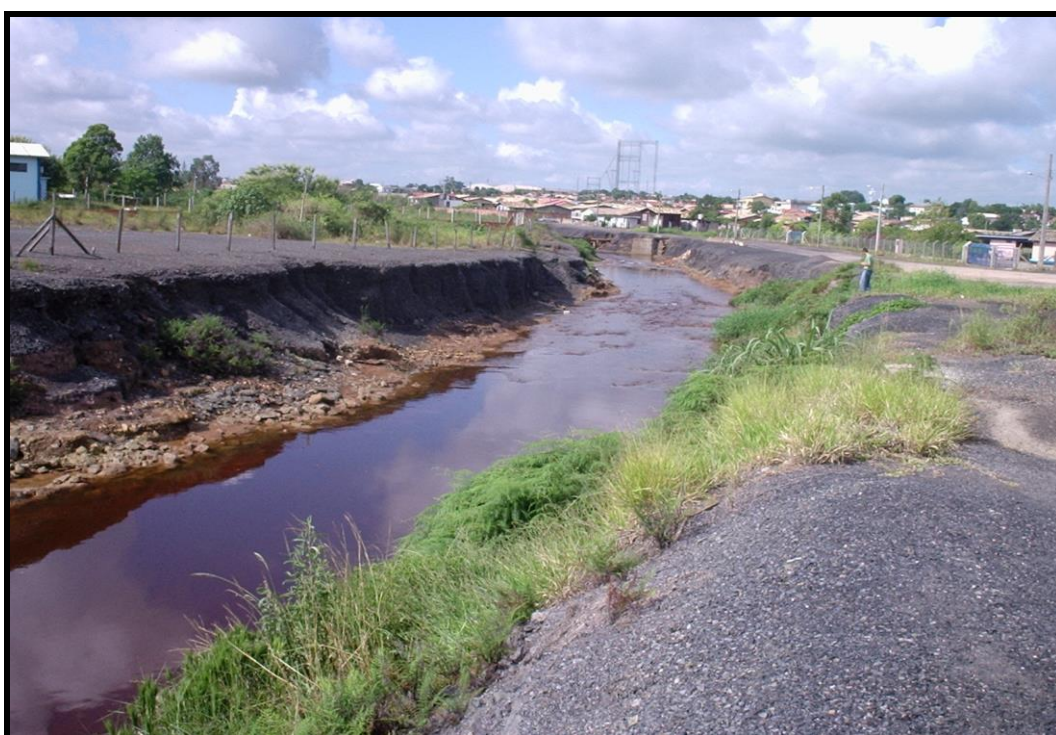
Figura 12: Aspecto das margens do rio Sangão. Observa-se a deposição de rejeitos do beneficiamento de carvão nas duas margens, e a água comprometida apresenta coloração vermelho-laranja, decorrente da alta concentração de íons Fe^{+3} . Localidade de Santa Augusta, município de Criciúma - SC.
