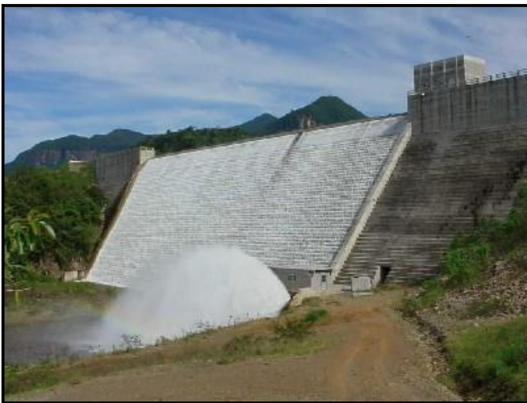
Figura 4: Vista da barragem do rio São Bento, município de Siderópolis/SC. Fonte: CASAN (2008).
