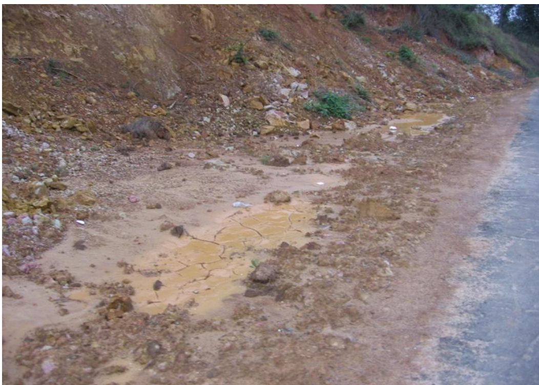
Figura 7 - Concentração de água no pé do talude.
