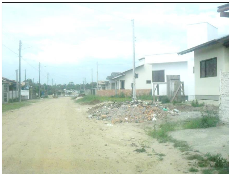
Figura 6 – Rua 1322 sem pavimentação.
