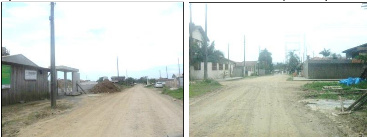
Figura 4 e 5 – Rua Bras. Cardoso Fernandes e Rua Noventa e Dois sem pavimentação.
