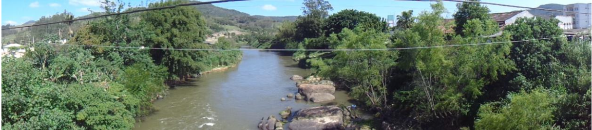
Figura 16 – PV06 - Vista panorâmica a partir da ponte em direção jusante do rio Capivari, evidenciando fundo rochoso próximo à margem direita e depósitos na margem esquerda. Presença de vegetação arbóreo-arbustiva nas APP das margens. Az: 90° à 245°
