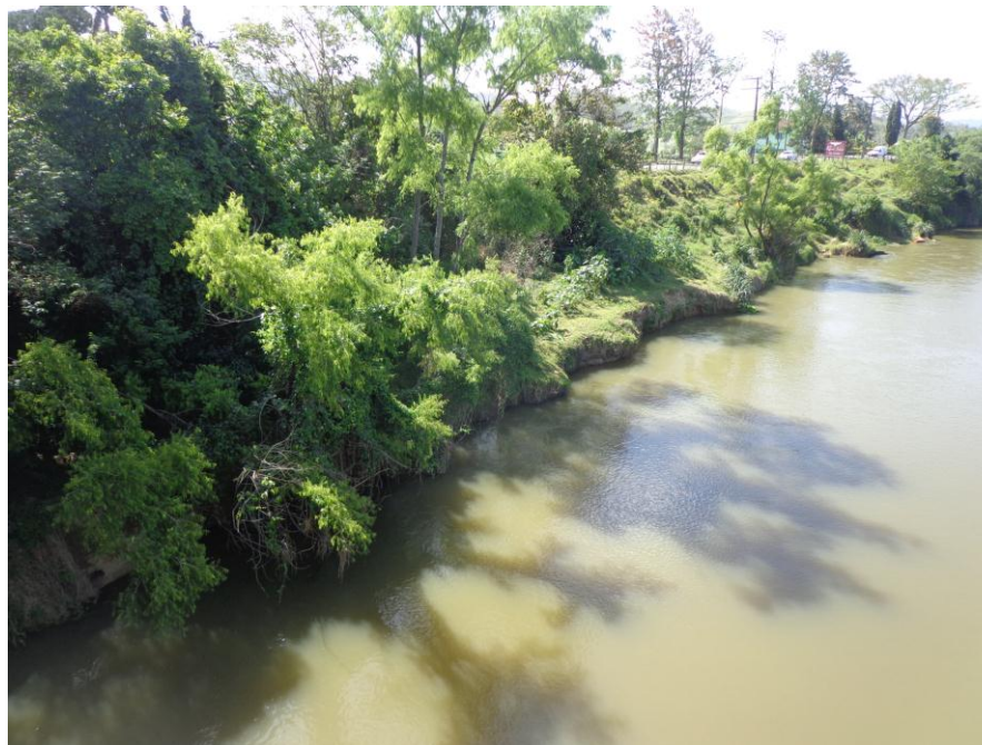
Figura 23 – PV06 – Detalhe da erosão na margem direita do rio Capivari. Az 335°
