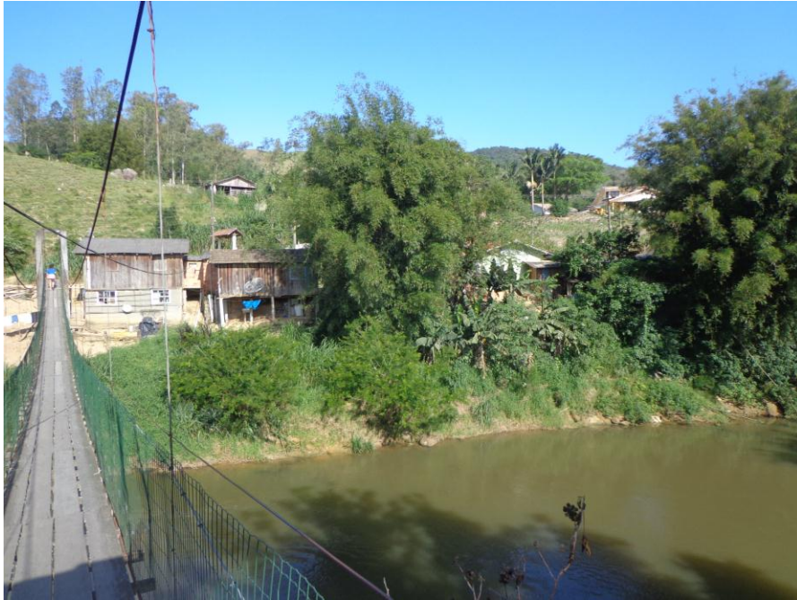
Figura 12 – PV10 - Ocupação urbana em APP às margens do rio Capivari. Az 180°
