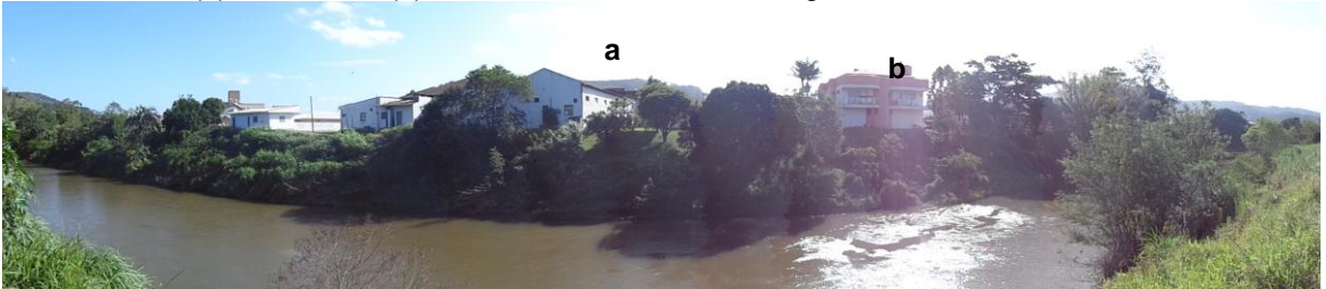
Figura 11 – PV12 – Vista panorâmica a partir da margem esquerda do rio Capivari, que mostra o clube de lazer (a) e o cartório (b), construídos em APP na margem direita deste rio. Az 180°
