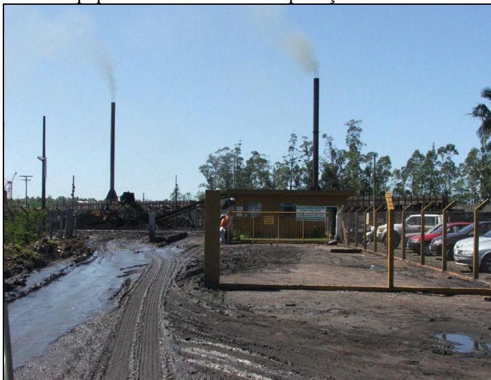
Figura 8 - Coqueria localizada na região de Criciúma. Observa-se a ausência de equipamentos de controle de poluição atmosférica.
