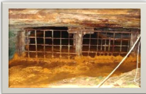
Figura 6 - Galeria de mina de carvão abandonada com geração de DAM.
