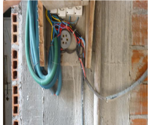
(Figura 13) – Rede energizada destrancada
