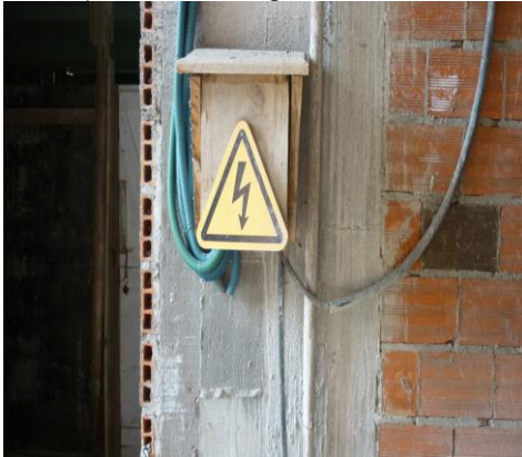
(Figura 12) – Rede energizada com sinalização
