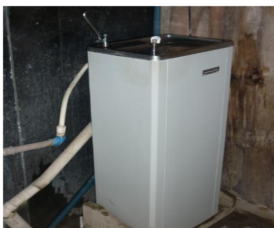
(Figura 19) - Bebedouro de jato inclinado. Fonte: Lucas Crispim
