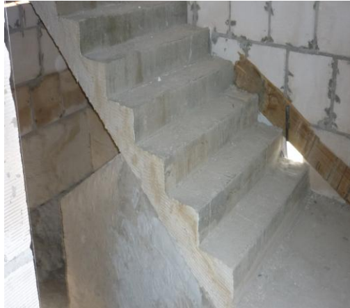
(Figura 7)- Escada desprotegida de guarda-corpo, corrimão e rodapé. Fonte: Lucas Crispim
