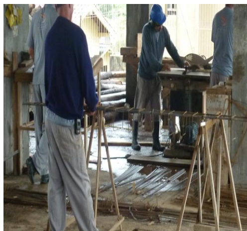
(Figura 14) – Motor sem proteção e EPI incompleto do operário. Fonte: Lucas Crispim
