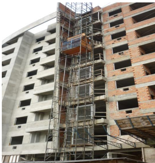
(Figura 10) - Torre do elevador. Fonte: Lucas Crispim
