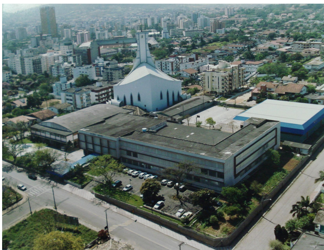
Figura 14:- Instalações Colégio Madre Teresa Michel atualmente.
