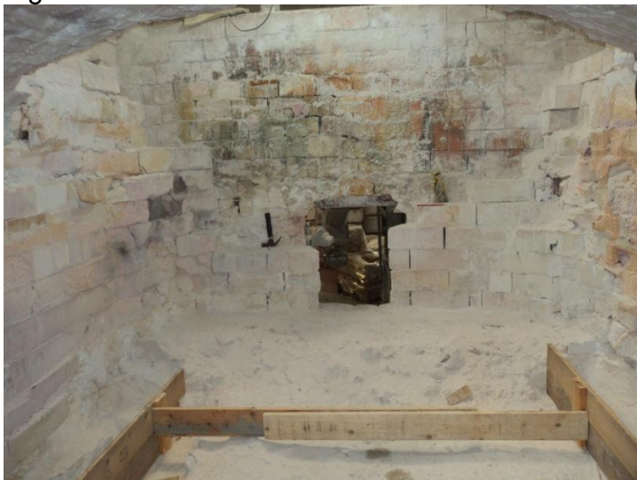
Figura 15– Interior forno de fritas em reforma
