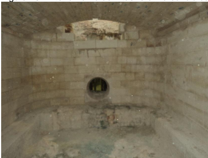
Figura 16– Interior forno de fritas reforma concluída
