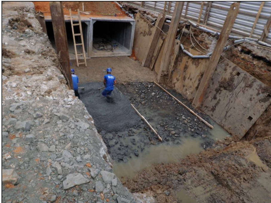
Figura 3 – Vista parcial da obra do canal auxiliar na Rua Coronel Pedro Benedet.
