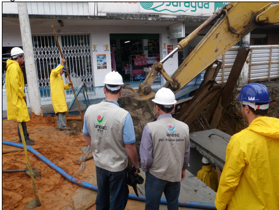
Figura 8 – Técnicos do IPAT/UNESC vistoriando a obra.
