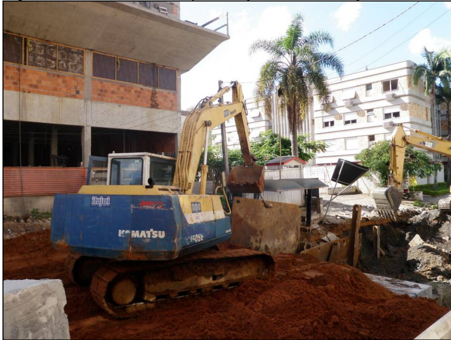
Figura 5 – Retirada da chapa de aço com a utilização de cabo de aço.
