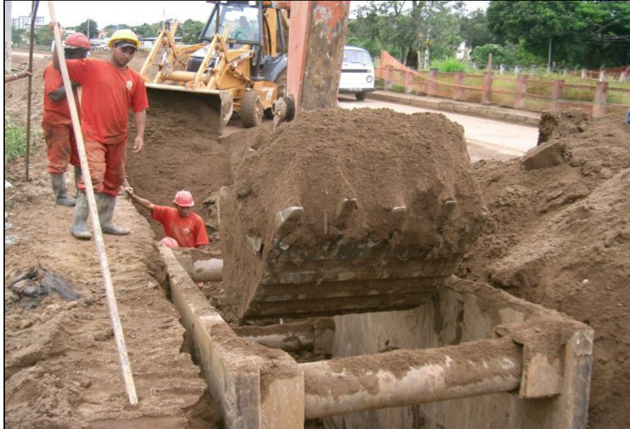
Figura 10 – Sistema de escoramento blindado, utilizado em valas.
