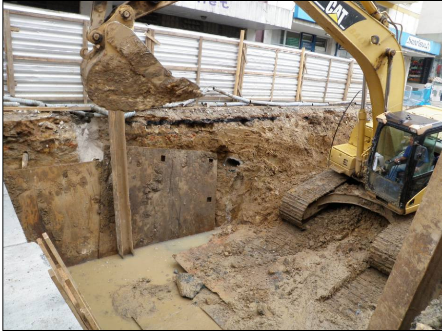
Figura 4 – Escavadeira cravando o perfil metálico para escorar e garantir a estabilidade do talude.
