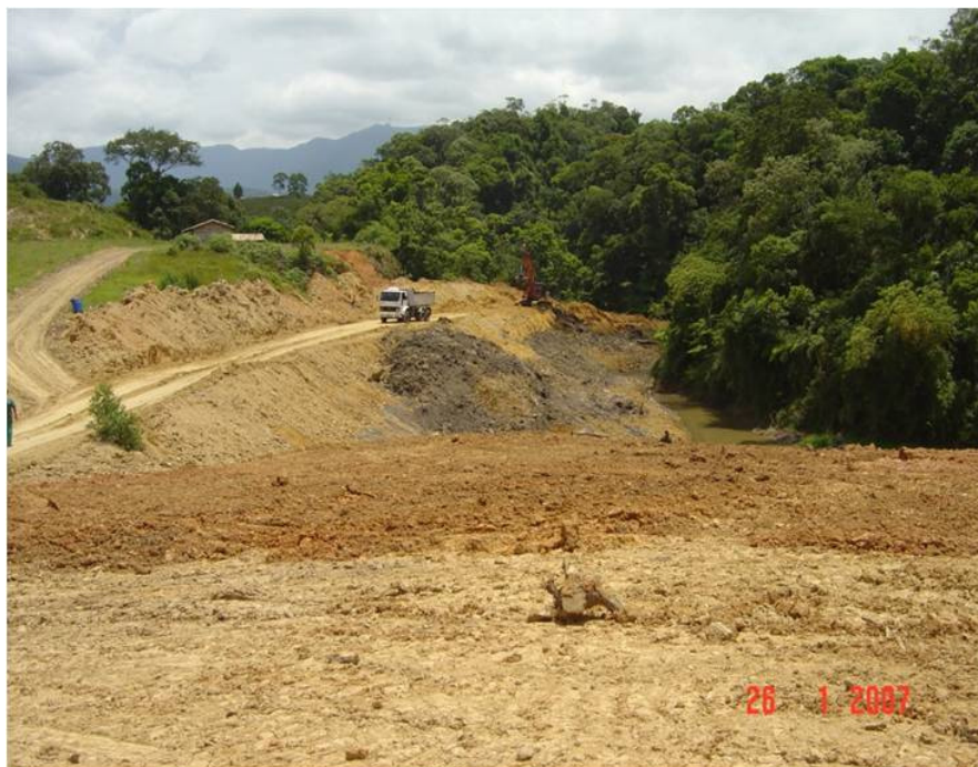
Figura 6: Área durante processo de recuperação
