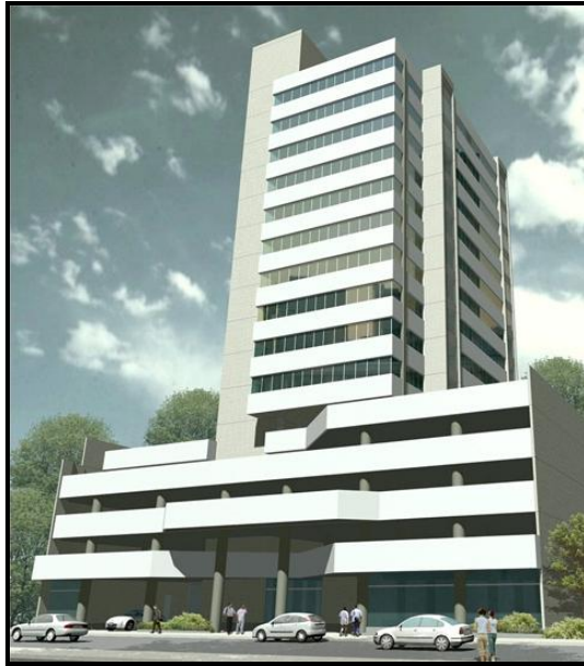
Figura 2 – Fachada Edifício Comercial.
