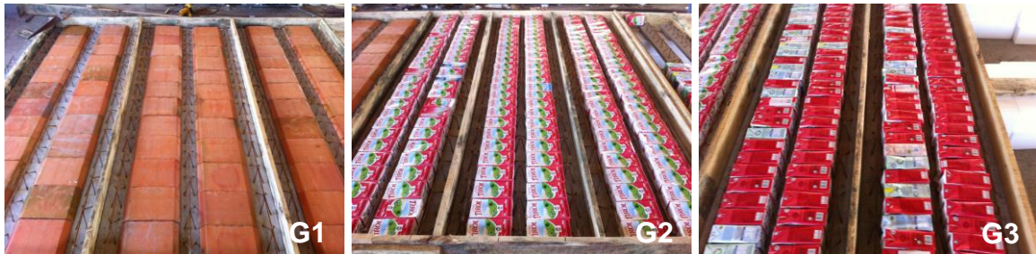
Figura 6 – Montagem das lajes G1, G2 e G3
