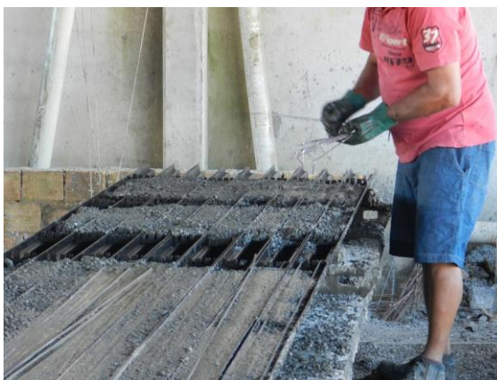
Figura 3: Posicionamento da armação nas vigotas
