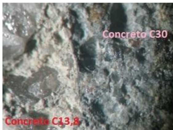
Figura 11 – Verificação da aderência do concreto na interface concreto da vigota/concreto novo.
