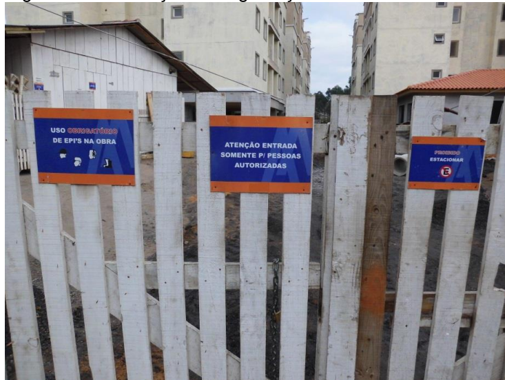
Figura 6 – Sinalização de segurança.
