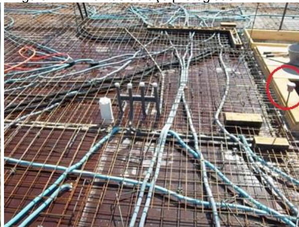
Figura 4B – Pontas de aço protegidas.
