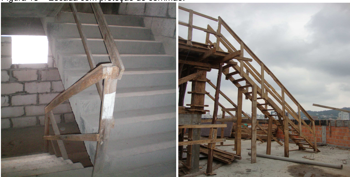
Figura 13 – Escada com proteção de corrimão.
