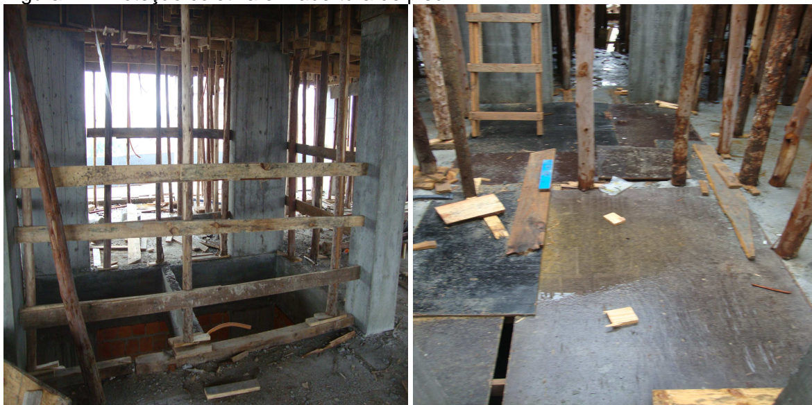
Figura 2 – Proteção coletiva em abertura de piso
