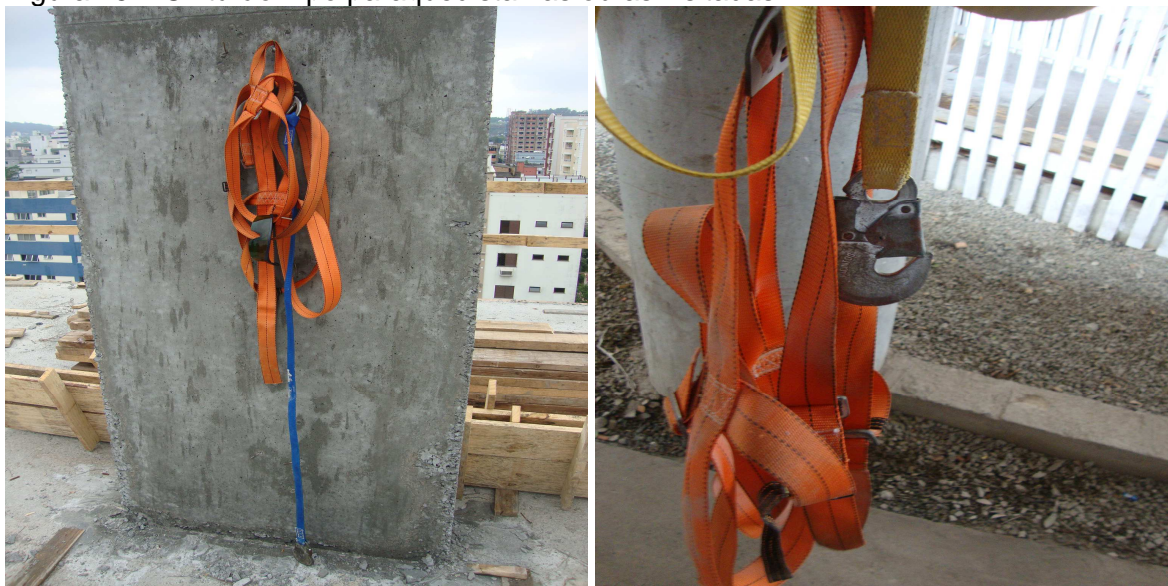
Figura 15 – Cinturão Tipo paraquedista nas obras visitadas.
