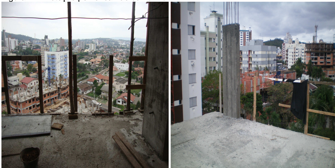
Figura 4 – Proteção periférica não conforme.
