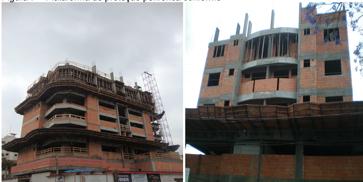
Figura 7 – Plataforma de proteção periférica conforme
