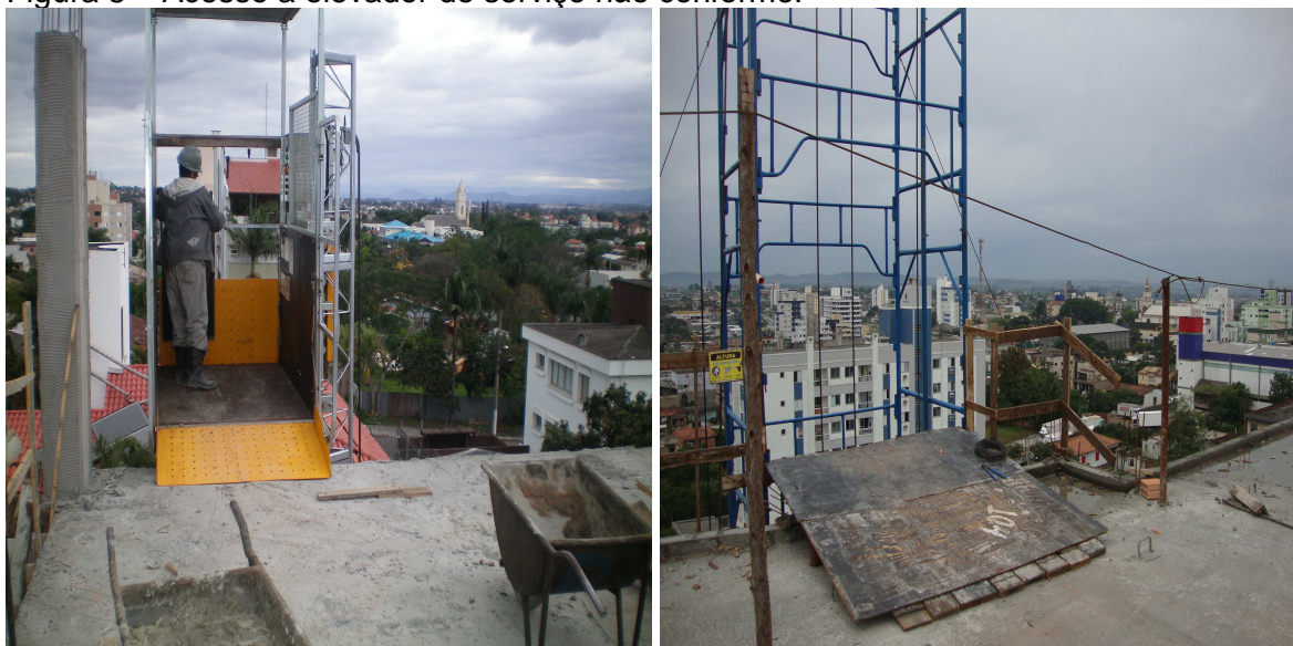
Figura 8 – Acesso a elevador de serviço não conforme.
