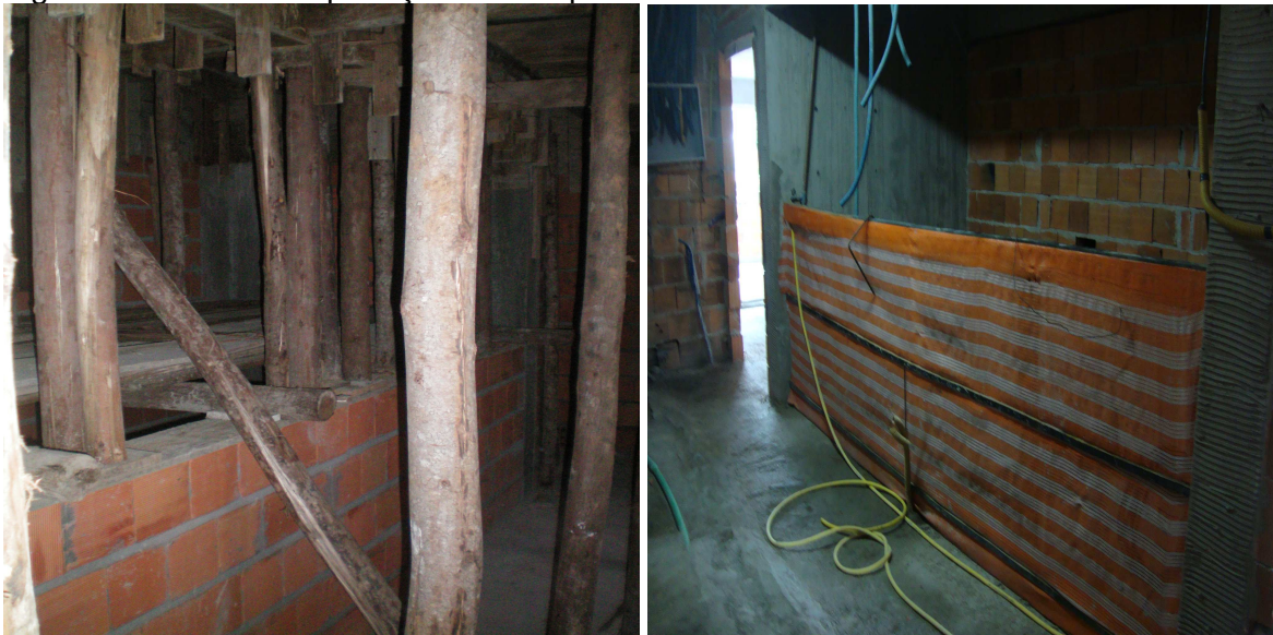
Figura 3 – Sistema de proteção contra quedas em abertura de vão do Elevador.
