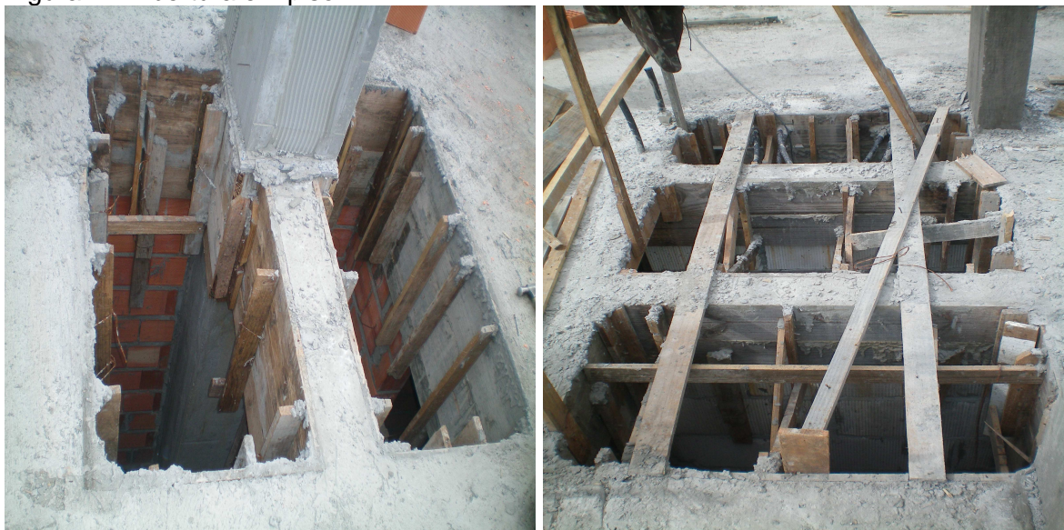
Figura 1 – Abertura em piso
