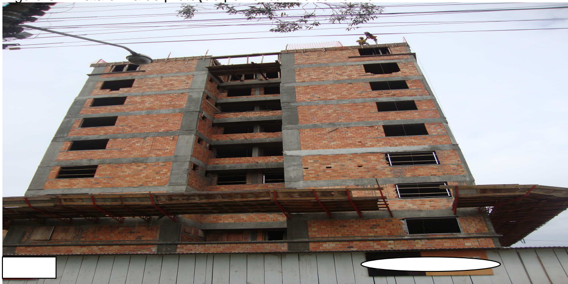
Figura 6 – Plataforma de proteção periférica não conforme
