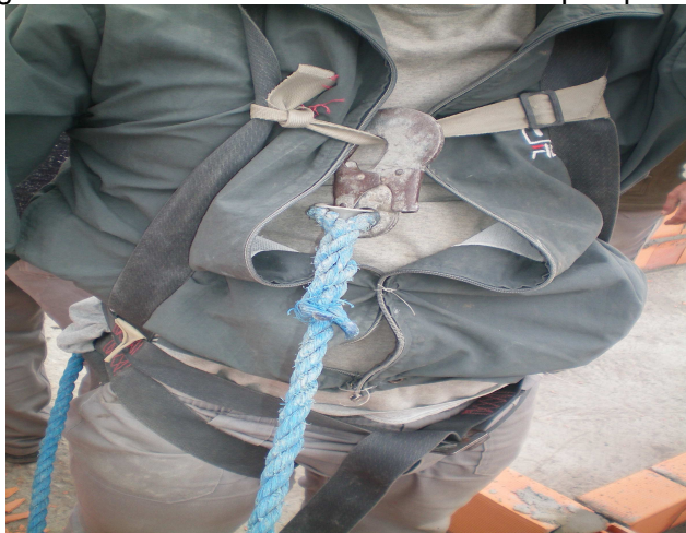
Figura 16 – Talabarte + cinturão em obra pesquisada.
