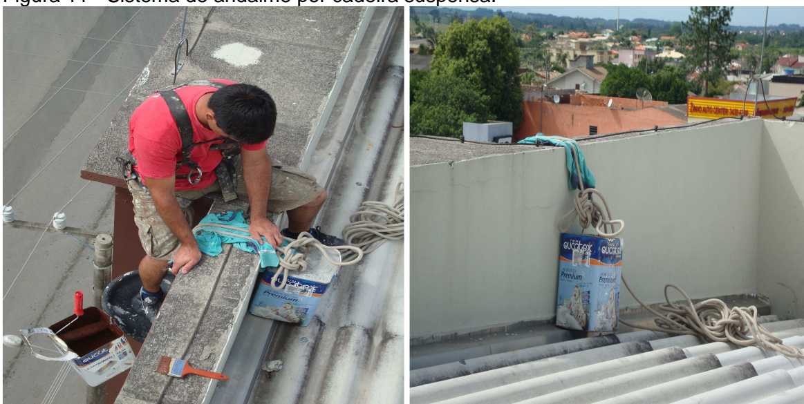
Figura 11 - Sistema de andaime por cadeira suspensa.
